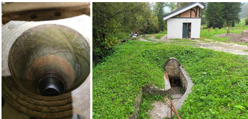
Slika 15: Levo: ustje vrtine VK-R, zgrajeno iz polirond cevi, ki se nahaja v jašku; Desno: Prosto dostopen izliv Rimskega vrelca je bil glavni iztok pred septembrom 2022.
