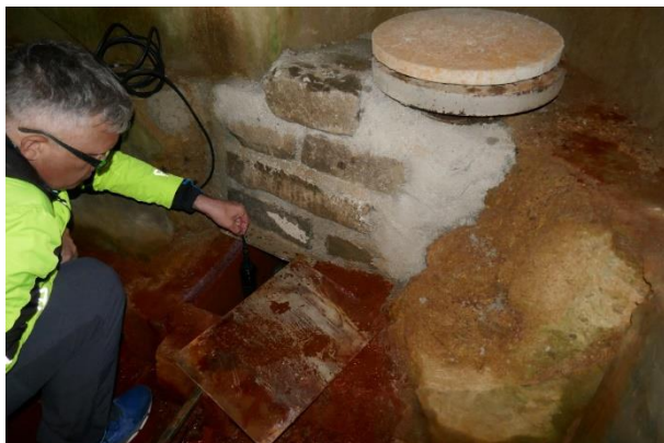
Slika 14: Jašek in betonska obloga, v kateri se nahaja vrtina VK-R (viden pokrov) s prelivom in cevjo, ki vodi do originalnega turistično urejenega iztoka.
