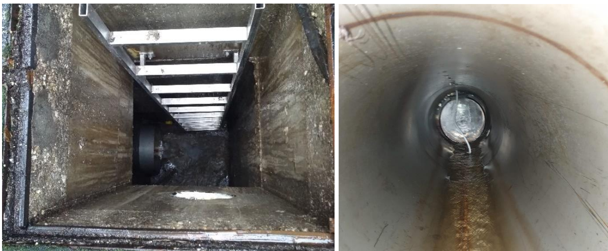
Slika 28: Mesto merilca pretoka (modra oprema na desni), katerega količine se zapisujejo na novem registratorju, ter mesto meritve gladine s sondo (levo, rdeča puščica) za določitev pretoka prelivne vode. (Desno) Nameščena merilna sonda za gladino in količino iztoka neuporabljene, prelivne vode.
