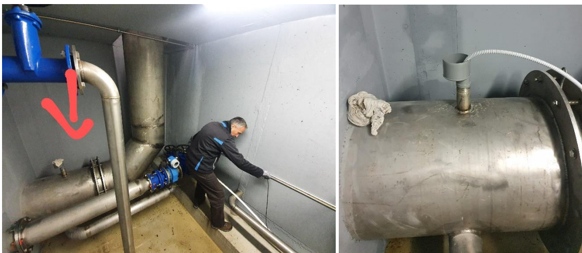
Slika 28: Mesto merilca pretoka (modra oprema na desni), katerega količine se zapisujejo na novem registratorju, ter mesto meritve gladine s sondo (levo, rdeča puščica) za določitev pretoka prelivne vode. (Desno) Nameščena merilna sonda za gladino in količino iztoka neuporabljene, prelivne vode.
