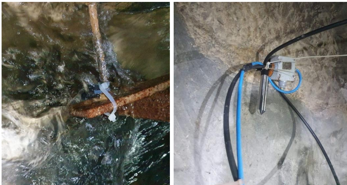
Slika 11: Merilno mesto v vodnem rovu ob merilni lati – potopljen dajver (levo) in drugi pod stropom (desno). Gladina se preračunava kot razlika obeh podatkov.
