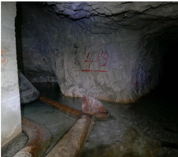
Slika 9: Nekoliko višje v rovu od merilnega mesta, sotočje dveh kanalov, kjer tudi izteka voda iz spodnjih rofov. Vpadnik Moring ima najnižjo koto 332 m, vpadnik Union pa 300 m.
