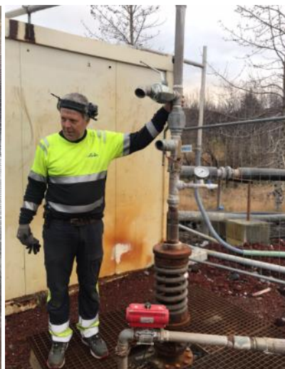
Slika 1 CO 2 postaja v kraju Hæðarendi, Burfellsvegur. Od leve proti desni: izpust CO 2 pod tlakom (levo), vertikalni toplotni izmenjevalec (sredina) in črpalna vrtina, iz katere črpajo vodo s temperaturo 103 °C na 700 m globine (desno). Foto: Mateja Macut. Posneto 26. 10. 2022.
