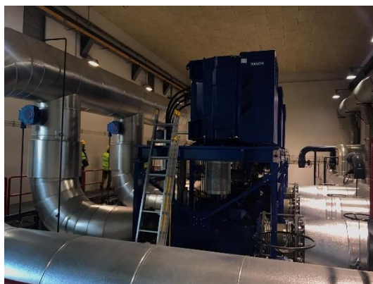
Slika 12 Distribucijski objekt Reynisvatnsheiðiwater (levo), notranjost objekta s tremi booster črpalkami (desno). Foto: Nina Rman (levo), Mateja Macut (desno). Posneto 28. 10. 2022.
