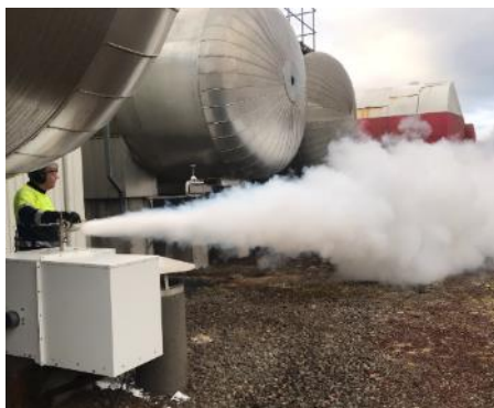
Slika 1 CO 2 postaja v kraju Hæðarendi, Burfellsvegur. Od leve proti desni: izpust CO 2 pod tlakom (levo), vertikalni toplotni izmenjevalec (sredina) in črpalna vrtina, iz katere črpajo vodo s temperaturo 103 °C na 700 m globine (desno). Foto: Mateja Macut. Posneto 26. 10. 2022.
