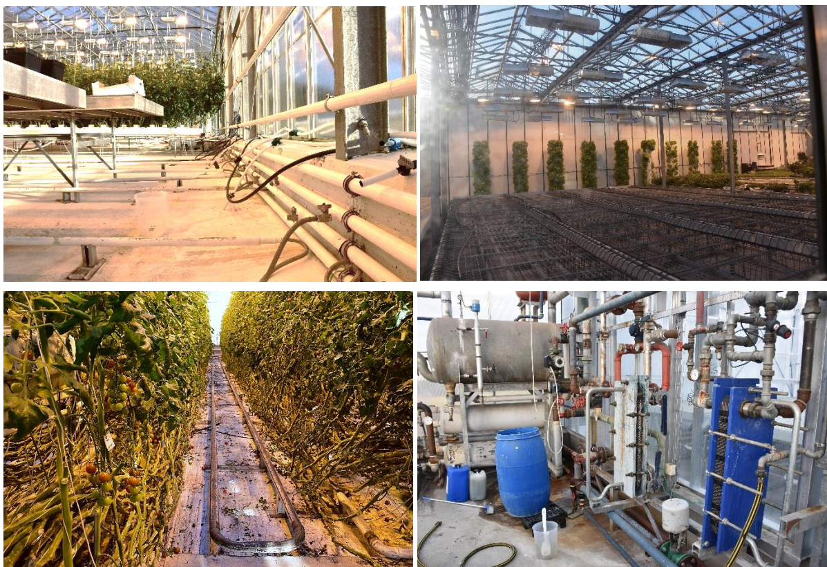
Slika 2: Prikaz različnih načinov cevnega ogrevanja geotermalnih rastlinjakov in strojnica manjšega rastlinjaka. Foto: N. Rman
