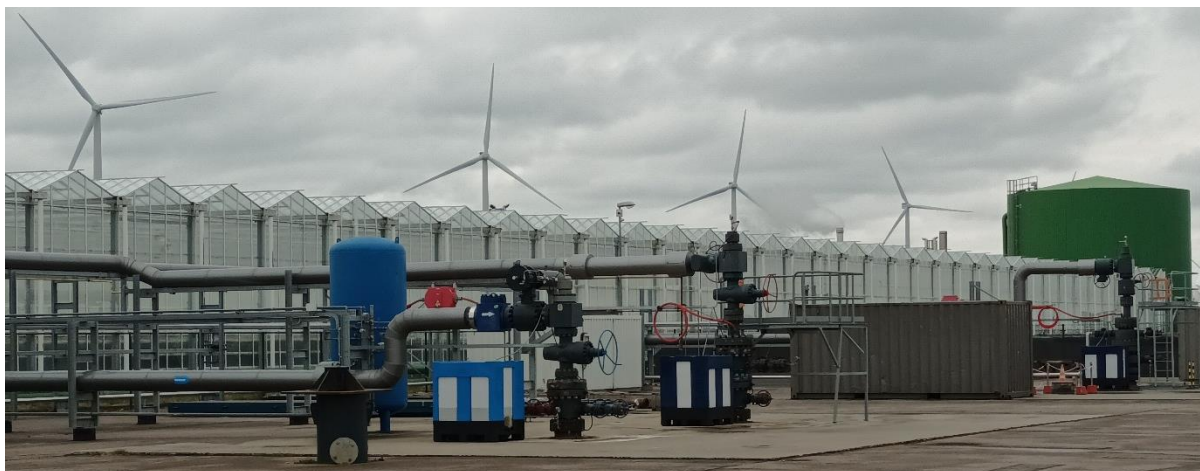
Slika 3: Dnevni zalogovnik (desni zeleni stolp) toplotne energije. Vetrnice služijo proizvodnji električne energije, geotermalne vrtnice v ospredju pa proizvajajo tudi zemeljski plin, ki ga s kogeneracijo pretvarjajo v električno energijo in toploto. Nastali CO 2 dodajajo rastlinam za hitrejšo rast. Primer nizozemskega rastlinjaka. Foto: N. Rman
