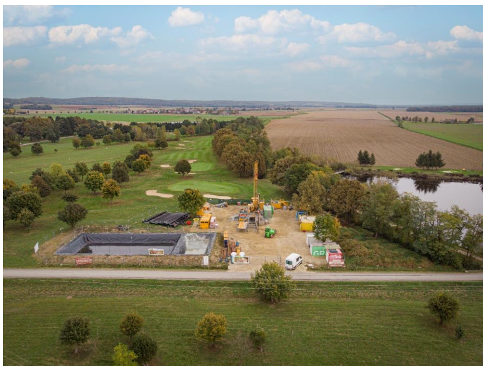
Slika 6: Priprava delovišča za vrtanje geotermalne vrtine v SV Sloveniji (foto S. Mozetič).
