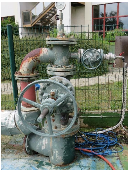
Slika 9: Ustje črpalke (levo) in reinjekcijske (desno) geotermalne vrtine.
