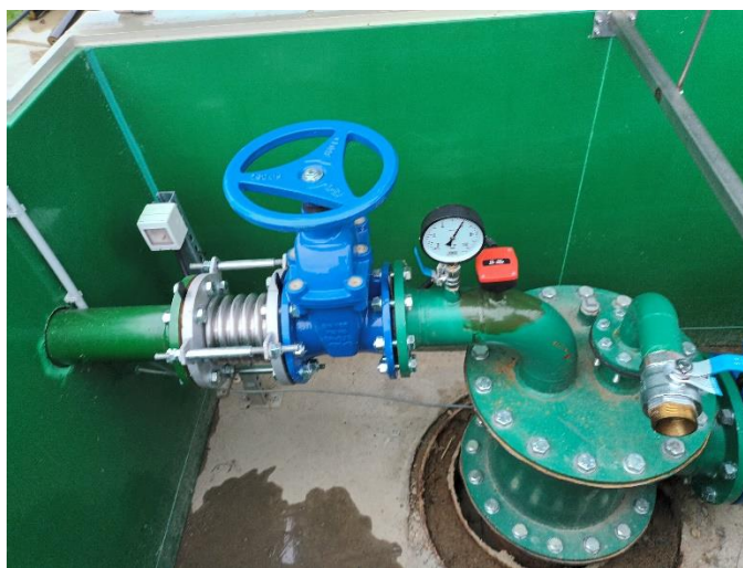
Slika 9: Ustje črpalke (levo) in reinjekcijske (desno) geotermalne vrtine.
